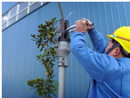
第三步 测量触指压力(未挂静触头)
