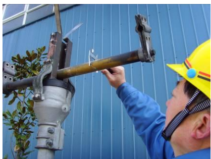
第一步 测量触头的宽度 a
