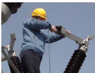
第三步 测量触指压力
