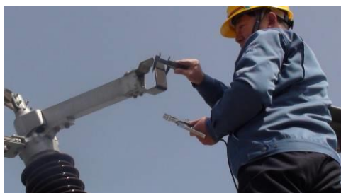
第一步 测量触头的宽度 a
